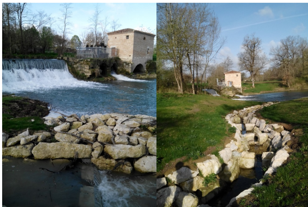
Figure 63 : Evaluation de l'efficacité de la rivière de contournement sur le site du Moulin de Castels (Tarn et Garonne) (a), site aménagé (b)
