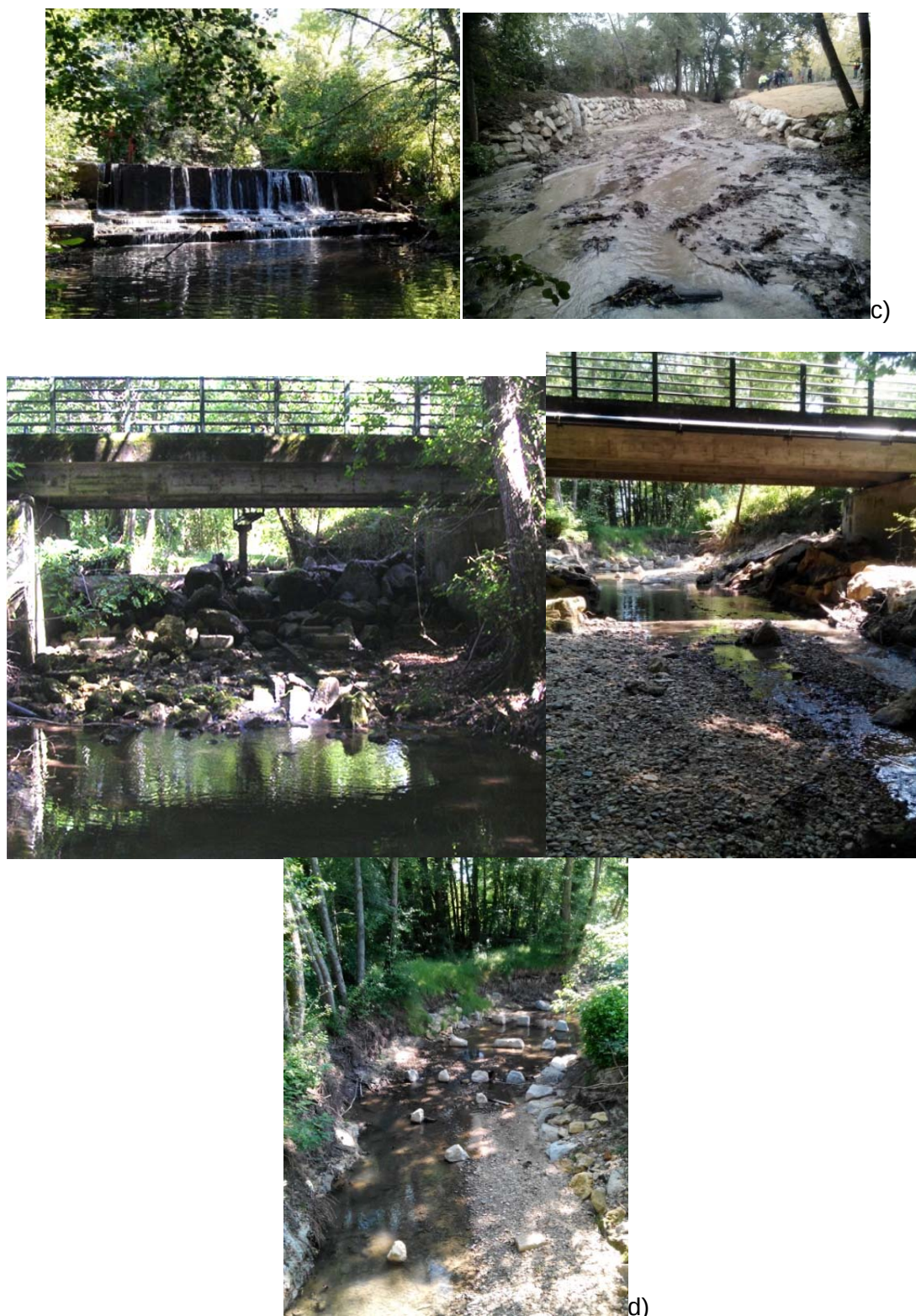
Figure 62 : Impact des ouvrages à la migration de montaison sur Barailler/Eyraud (a), évolution des densités totales d'anguille (b), arasement de l'ouvrage aval, Moulin du Coutou c), démantèlement et réaménagement du seuil de répartition du Pont de Chadeau d)
