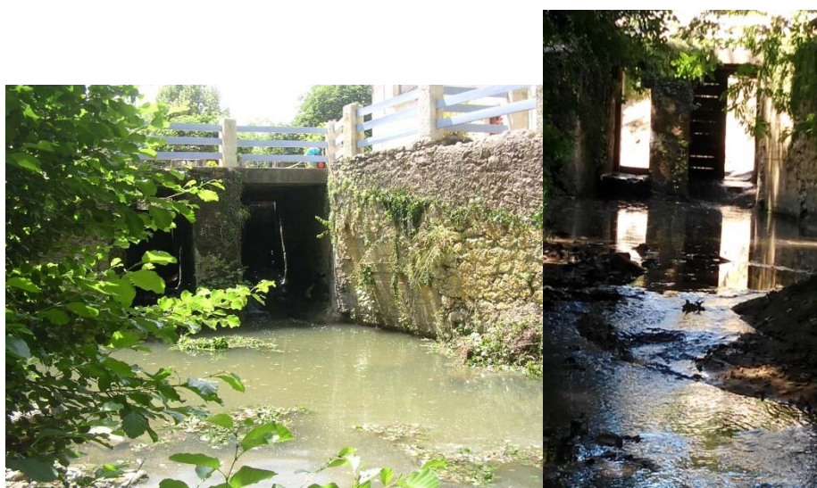
Figure 61 : Impact des ouvrages à la migration de montaison sur la Soulège (a), premier ouvrage aval Moulin de Moustelat avant ouverture des vannes et après ouverture des vannes en 2015 (b).
