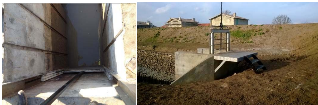
Figure 45 : Ouvrage modifié, automne 2013. Source : Anteagroup, 2013.
