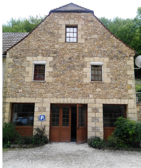
Figure 21 : Portes de la salle ERP de Castels
