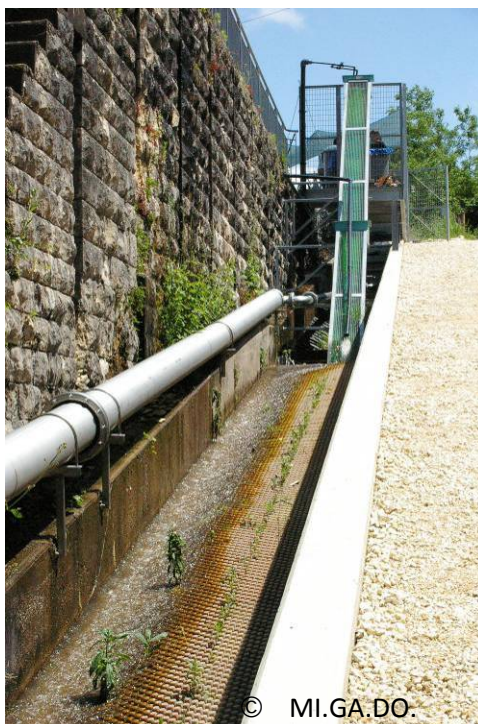
Figure 22 : Nouvelle passe à anguilles installée sur le site de Tuilières en 2010.
