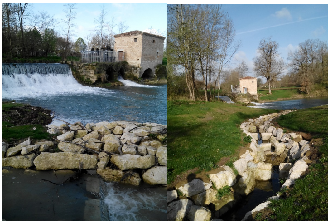
Figure 19 : Evaluation de l'efficacité de la rivière de contournement sur le site du Moulin de Castels (Tarn et Garonne) (a), site aménagé (b)
