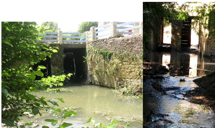
Figure 17 : Impact des ouvrages à la migration de montaison sur la Soulège (a), premier ouvrage aval Moulin de Moustelat avant ouverture des vannes et après ouverture des vannes en 2015 (b).
