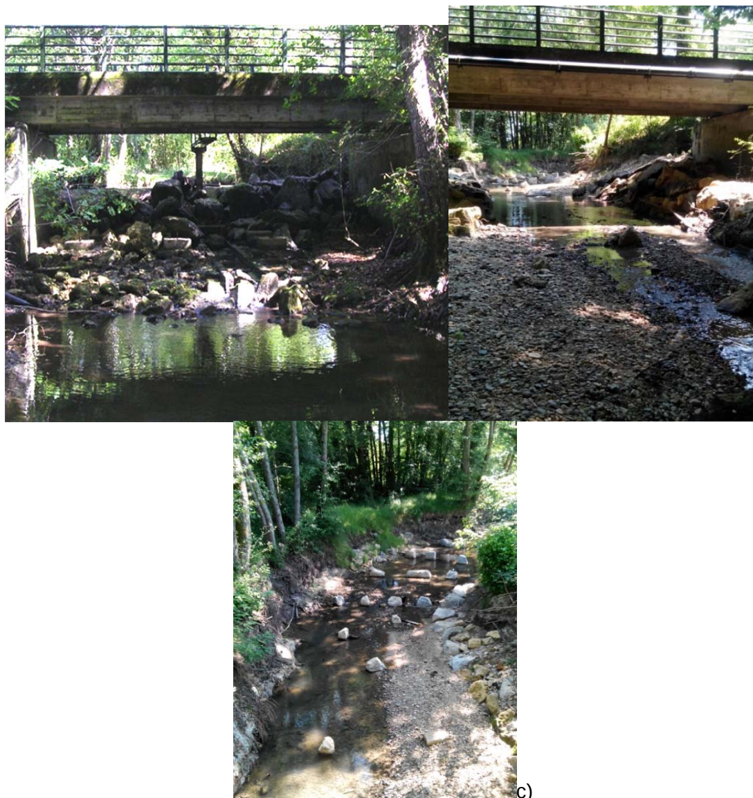
Figure 18 : Impact des ouvrages à la migration de montaison sur Barailler/Eyraud (a), arasement de l'ouvrage aval, Moulin du Coutou b), démantèlement et réaménagement du seuil de répartition du Pont de Chadeau c)
