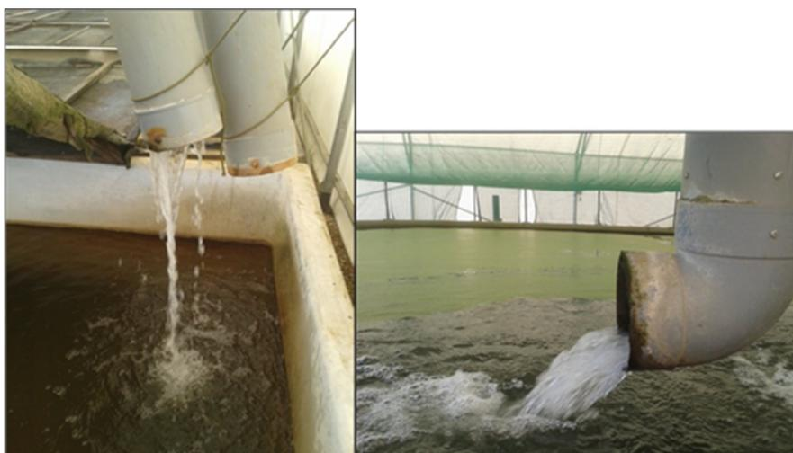
**Figure 7 : Types d'arrivée d'eau dans les bassins : verticale (à gauche) et horizontale (à droite)**
