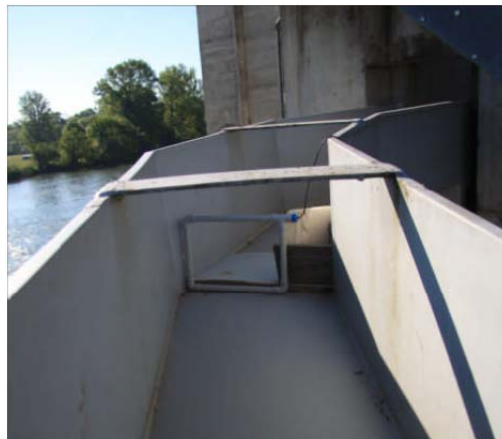
Photo 6 : Dispositif de détection du piège de Pointis
