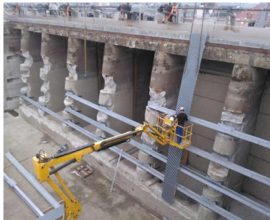
Photo 7 : Pose des modules du plan de grille (2 cm) à Camon
