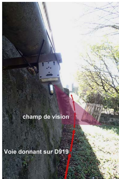
Figure n°11. Déplacement du piège du pont de l'Alses pour visualiser le passage sur un accès dangereux (gauche)
