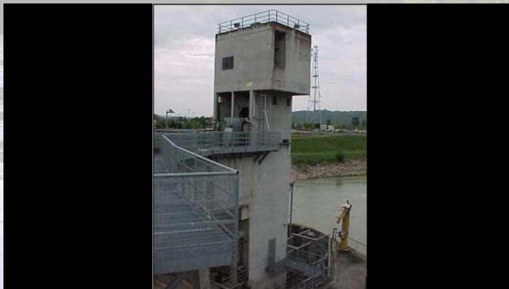
Ascenseur à poissons
