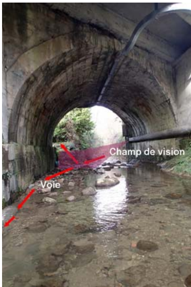
Figure n°9. Piège en rive droite posé sur le pont de l'Aises
