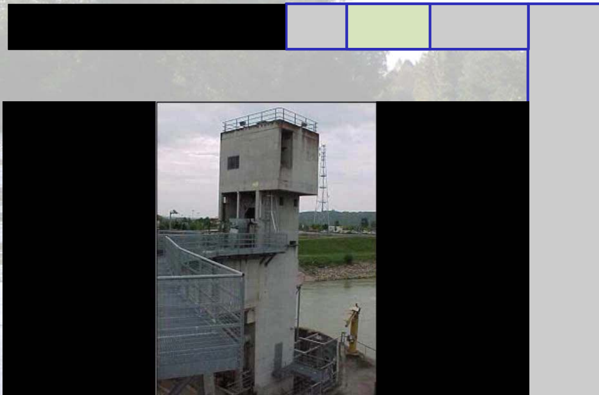
Ascenseur à poissons
