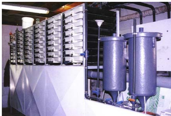
Figure 2 : Pisciculture de Pont Crouzet : plate-forme d'élevage et éclosion en circuit fermé
