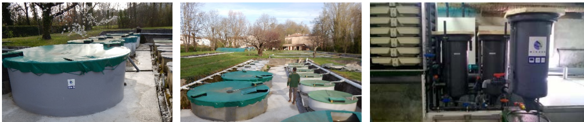
Figure 4 : Travaux et installations 2015 à Pont Crouzet : nouveau bassin circulaire dalles de ciment installés sur la plateforme d'élevage (photo de gauche et du centre) et 3 ème incubateur ajouté à l'écloserie en circuit fermé (photo de droite)
