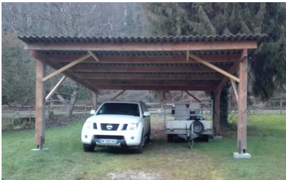
Photographie 8 : Abri construit en 2016.
