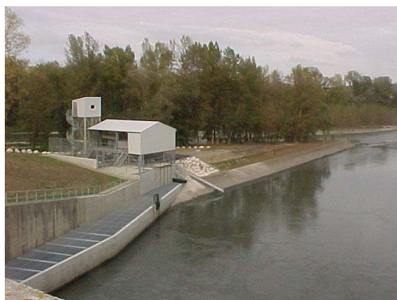
Photo 2 : La station de piégeage de Carbonne sur la Garonne
