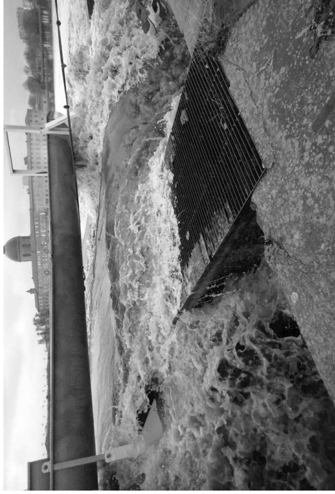
Passé à ralentisseurs, submersion lors de la crue du 26 novembre
