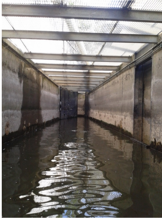
Photo 1 : Vue du canal collecteur
