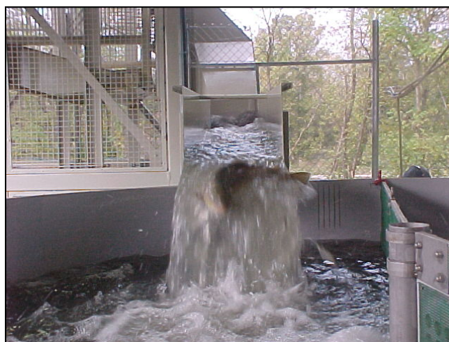
Photo 2 : Déversement d'un salmonidé dans la goulotte de l'ascenseur
