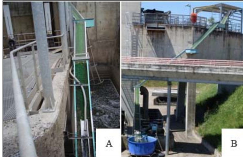
Figure 19 : La passe à anguilles actuelle de Golfech. En A, la passe partie inférieure, en B, la passe partie supérieure.
