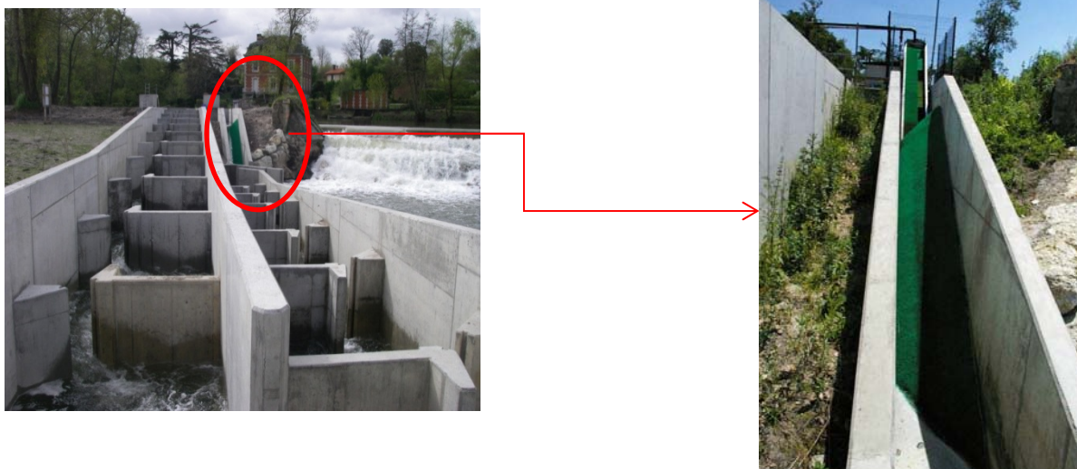
Photo 13 : Passes à poissons de Monfourat (passe à bassins et rampe à anguilles)
