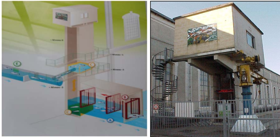
Photo 1 : Vue et schéma de l'ascenseur à poissons de Tuilières (Source EDF)
