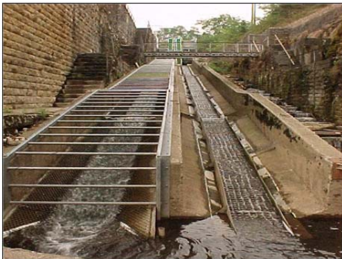
Photo 7 et Photo 8 : Partie aval et amont de la passe à anguilles
