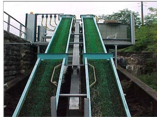
Photo 7 et Photo 8 : Partie aval et amont de la passe à anguilles
