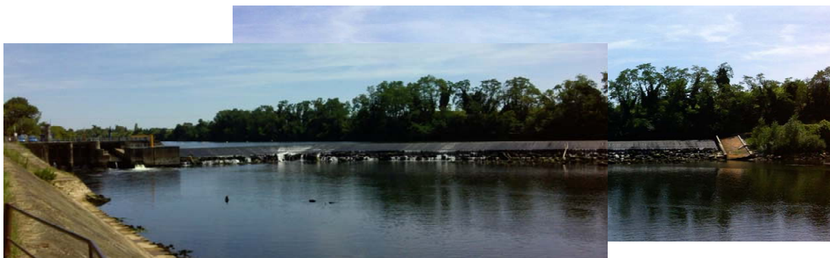
Figure 28 : Barrage de Bergerac lors de la remise en eau de la retenue le 11/05/15 à 14h30.
