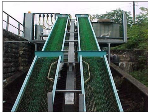
Figures 11 et 12 : Partie aval et amont de la passe à anguilles
