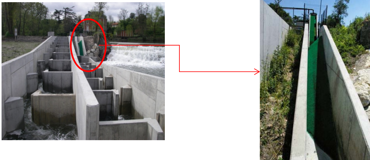
Photo 7 : Passes à poissons de Monfourat (passe à bassins et rampe à anguilles)
