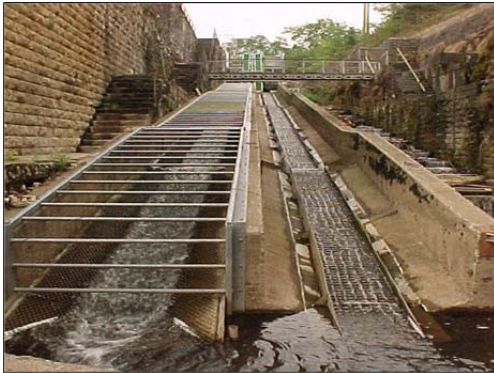
Figures 11 et 12 : Partie aval et amont de la passe à anguilles
