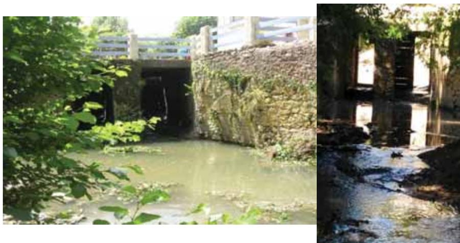
**Figure 39 : Impact des ouvrages à la migration de montaison sur la Soulège (a), premier ouvrage aval Moulin de Moustelat avant ouverture des vannes et après ouverture des vannes en 2015 (b).**
