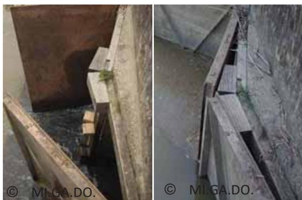
**Figure 35 : Des cales en chêne au niveau des portes à flot d'Arcins, à marée basse (portes à flot ouvertes) et à marée montante (portes à flot fermées laissant une ouverture de 10 cm sur toute la hauteur).**
