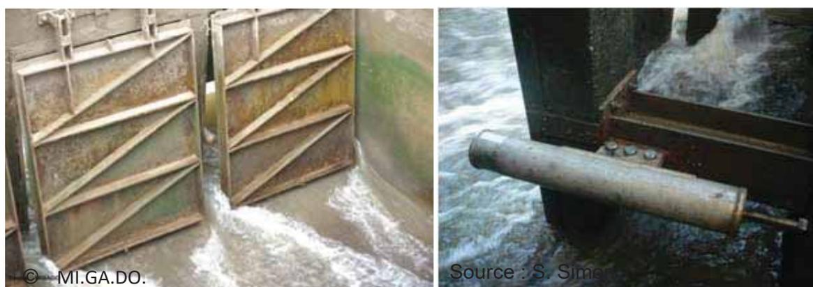
**Figure 37 : Raidisseurs installés sur les clapets de la jalle du Breuil. Source : MIGADO et S. Simon, 2010**
