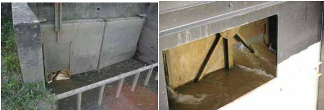
Figure 39 : Vante ouverte sur les portes à flot d'Issan, vue de l'aval et de l'amont.
