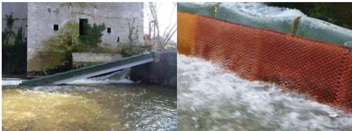
**Figure 42 : Franchissabilité des obstacles à la montaison sur la Gélise (a), passe à canoë et nouveau tapis de reptation (b)**
