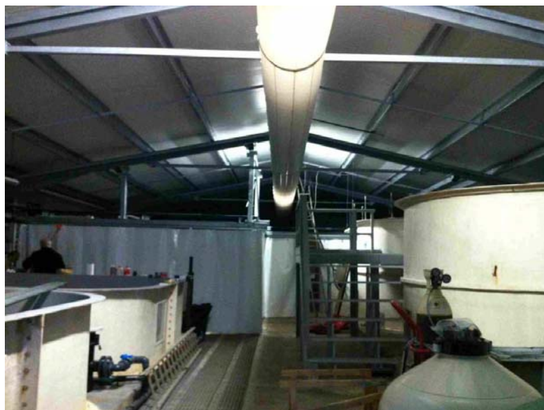
Figure 11 : Bâtiment Sturio 1 (bassins juvéniles en premier plan et circuits fermés) et bache de séparation
