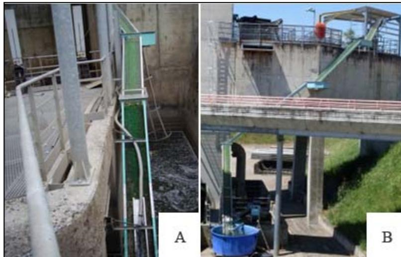
**Figure 26 : La passe à anguilles actuelle de Golfech. En A, la passe partie aval, en B, la passe partie amont avec le bassin tampon (bleu).**
