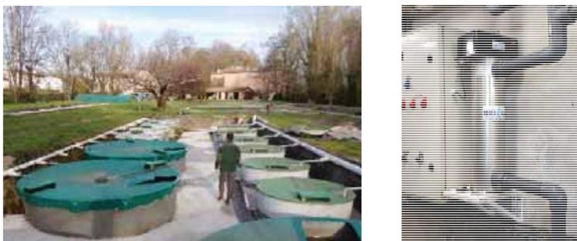
**Figure 1 : Travaux et installations 2017 à Pont Cruzet : dalles de ciment réalisées entre les bassins extérieurs de la plateforme d'élevage (photo de gauche) et changement du système traitement UV de l'eau de l'écloserie (photo de droite)**
