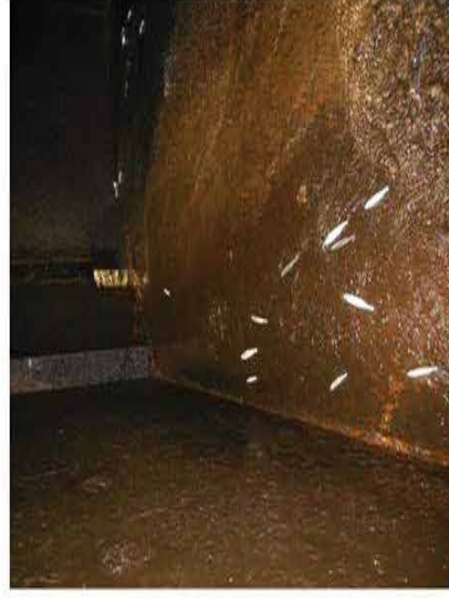
Cyprinidés mis à sec lors d'un arrêt de la passe à bassins
