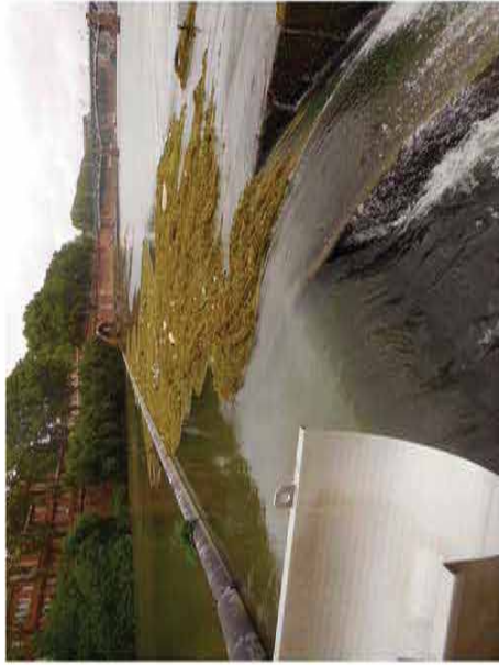
Accumulation à la drôme de l'usine et dégrilleur bloqué par renoncles fin juin et juillet
