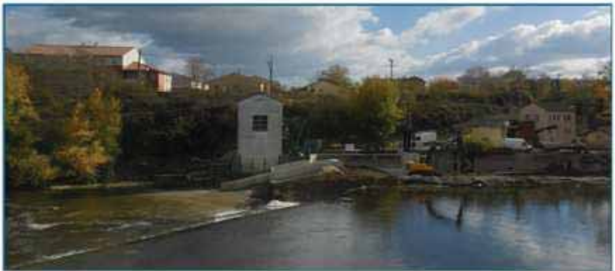
Travaux en rivière à Saverdun le 14/11 : mise en suspension à l'aval
