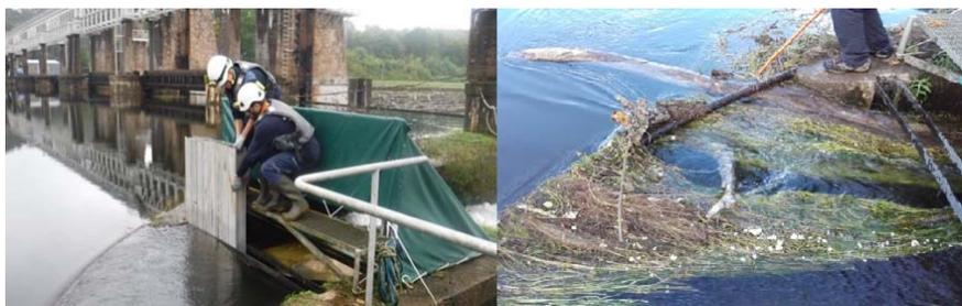
**Photo 19 : Batardage et colmatage de la passe à ralentisseurs**
