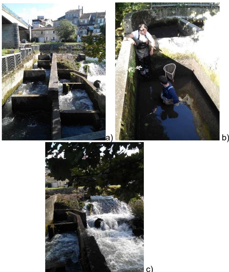
**Photo 4 : La passe de Coutras (a- passe à bassin en cours de vidange, b- entretien de la passe (désensablement et désencombrement), et c- passe à anguilles)**
