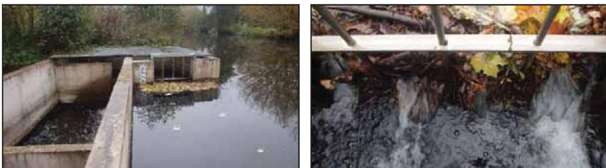
Photo 12 : passe à poissons de la digue du Bayle sur la Bave
