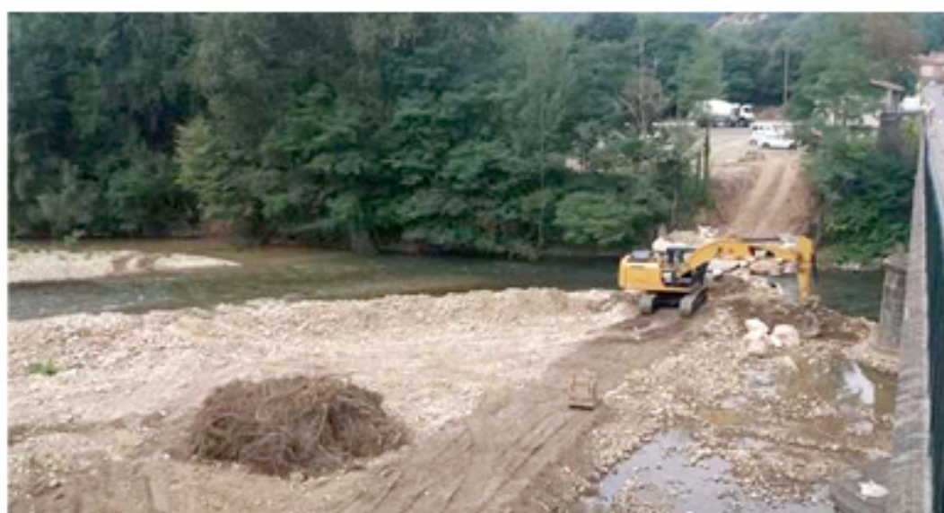
TRAVAUX EN RIVIERE A BONNAC (confortement des appuis amont du pont) photo du 11/09 (source article LA DEPECHE DU MIDI du 11/09/2018)
