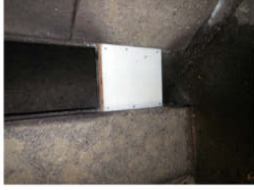
Exemple de rénovation de seuils interbassins en bois, dégradé et changé
