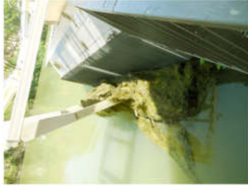
Dégrilleur bloqué par renoncules
