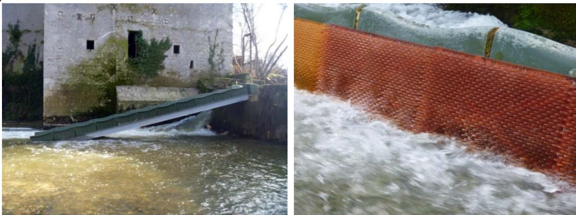
**Figure 61 : Franchissabilité des obstacles à la montaison sur la Gélise (a), passe à canoë et nouveau tapis de reptation (b)**
