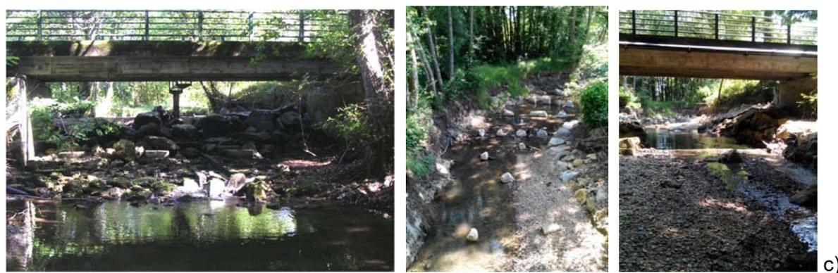
**Figure 59 : Impact des ouvrages à la migration de montaison sur Barailler/Eyraud (a), arasement de l'ouvrage aval, Moulin du Coutou b), démantèlement et réaménagement du seuil de répartition du Pont de Chadeau c)**
