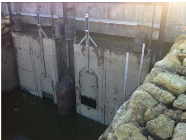
**Figure 47 : Porte à flot de Despartins aménagée avec une vanne haute et une vanne basse.**
