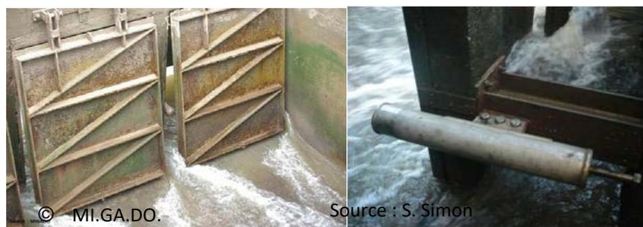
**Figure 41 : Raidisseurs installés sur les clapets de la jalle du Breuil. Source : MIGADO et S. Simon, 2010**
