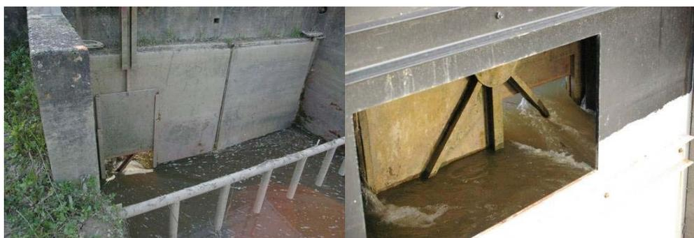
**Figure 43 : Vantelle ouverte sur les portes à flot d'Issan, vue de l'aval et de l'amont.**
