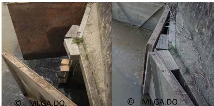
**Figure 39 : Des cales en chêne au niveau des portes à flot d’Arcins, à marée basse (portes à flot ouvertes) et à marée montante (portes à flot fermées laissant une ouverture de 10 cm sur toute la hauteur).**
