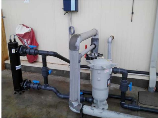
**Figure 15 : Caisson UV et filtre à poche installé à l'entrée de chaque bâtiment Sturio 1 et Sturio 2 sur le circuit d'eau de mer.**
