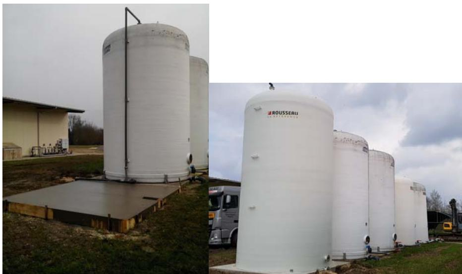
**Figure 14 : Dalle béton et nouvelle cuve de stockage d'eau de mer.**
