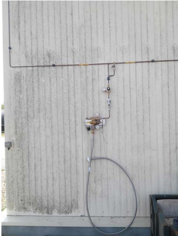
**Figure 13 : Platine d'alimentation du cricuit de secours d'oxygène du bâtiment Sturio 2.**
