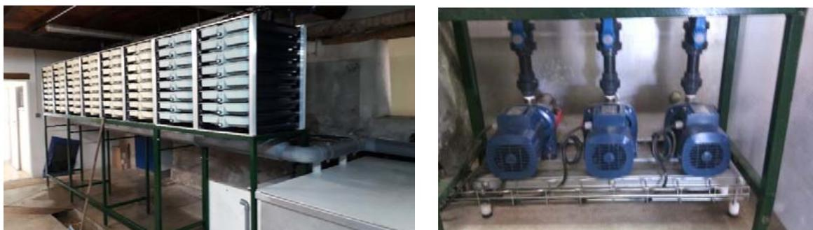
**Figure 1 : Travaux et installation 2018 à Pont Cruzet : 2 nouvelles colonnes de tiroir d'éclosion (photo de gauche) et 3 pompes de recirculation de l'eau de l'écloserie (photo de droite)**
