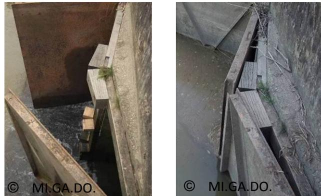
**Figure 37 : Des cales en chêne au niveau des portes à flot d'Arcins, à marée basse (portes à flot ouvertes) et à marée montante (portes à flot fermées laissant une ouverture de 10 cm sur toute la hauteur).**
