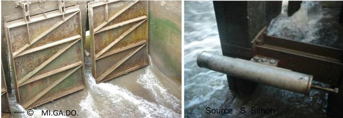
**Figure 39 : Raidisseurs installés sur les clapets de la jalle du Breuil. Source : MIGADO et S. Simon, 2010**
