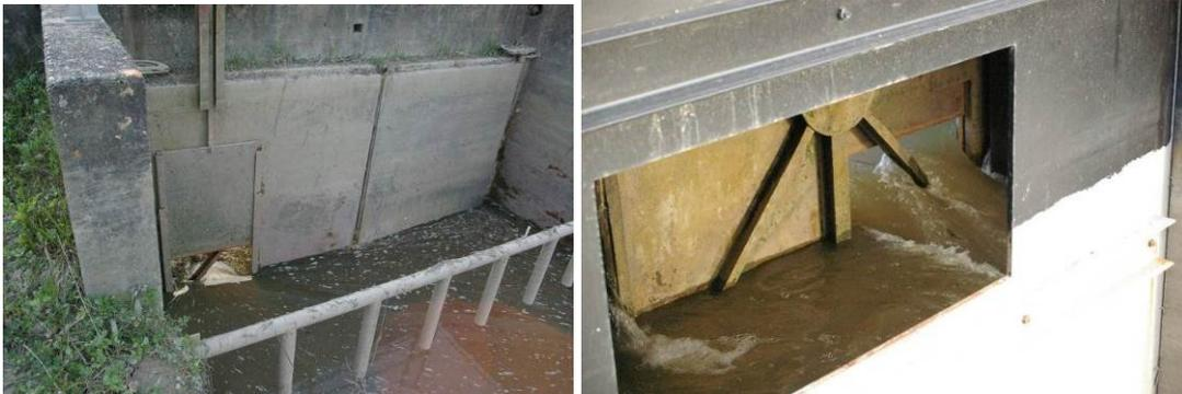
Figure 41 : Vantelle ouverte sur les portes à flot d’Issan, vue de l’aval et de l’amont.
