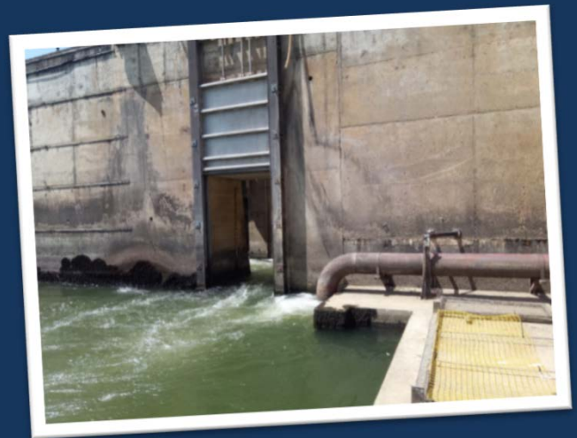
Vue de l'entrée 2 de l'ascenseur à poissons de Golfech
