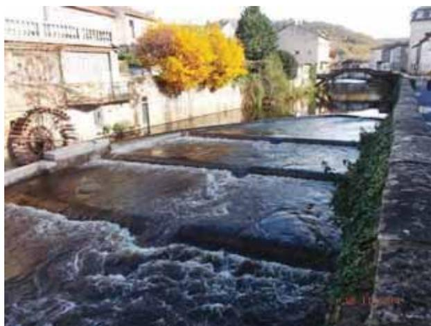
*Photo 14 : Le seuil des Récollets dans St Céré équipé d'une succession de pré-barrages*
