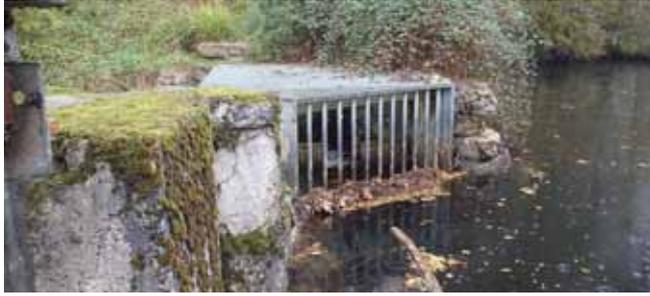
*Photo 15 : L'entrée de la passe à bassins au niveau de la digue de Rouquette*
