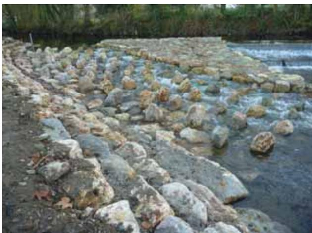
*Photo 13 : Le seuil de la Ségarie équipé d'une rampe en enrochements à macro-rugosités régulièrement réparties*
