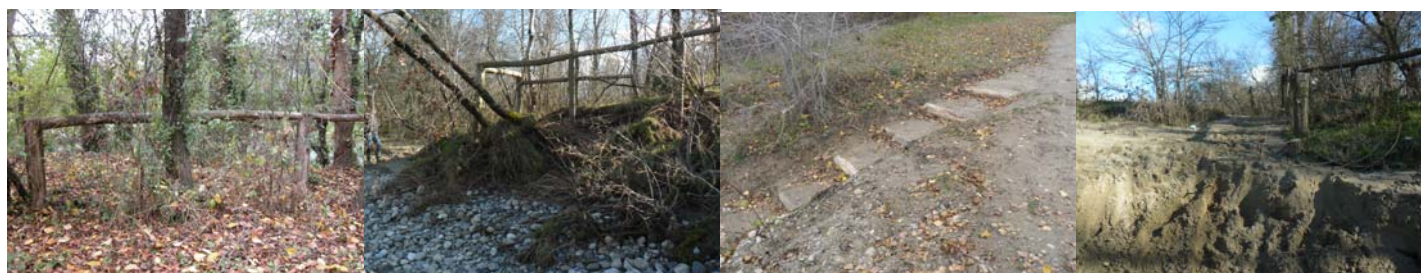
Barrières dans la forêt alluviale de Clermont-le-Fort (MIGADO ©) puis suite à la crue de 2014, barrière nécessitant une intervention ponctuelle (Sicoval ©) et gradine permettant l'accès à la première plage (MIGADO ©) puis suite à la crue de 2014, gradine totalement recouverte de limon (Sicoval ©)
