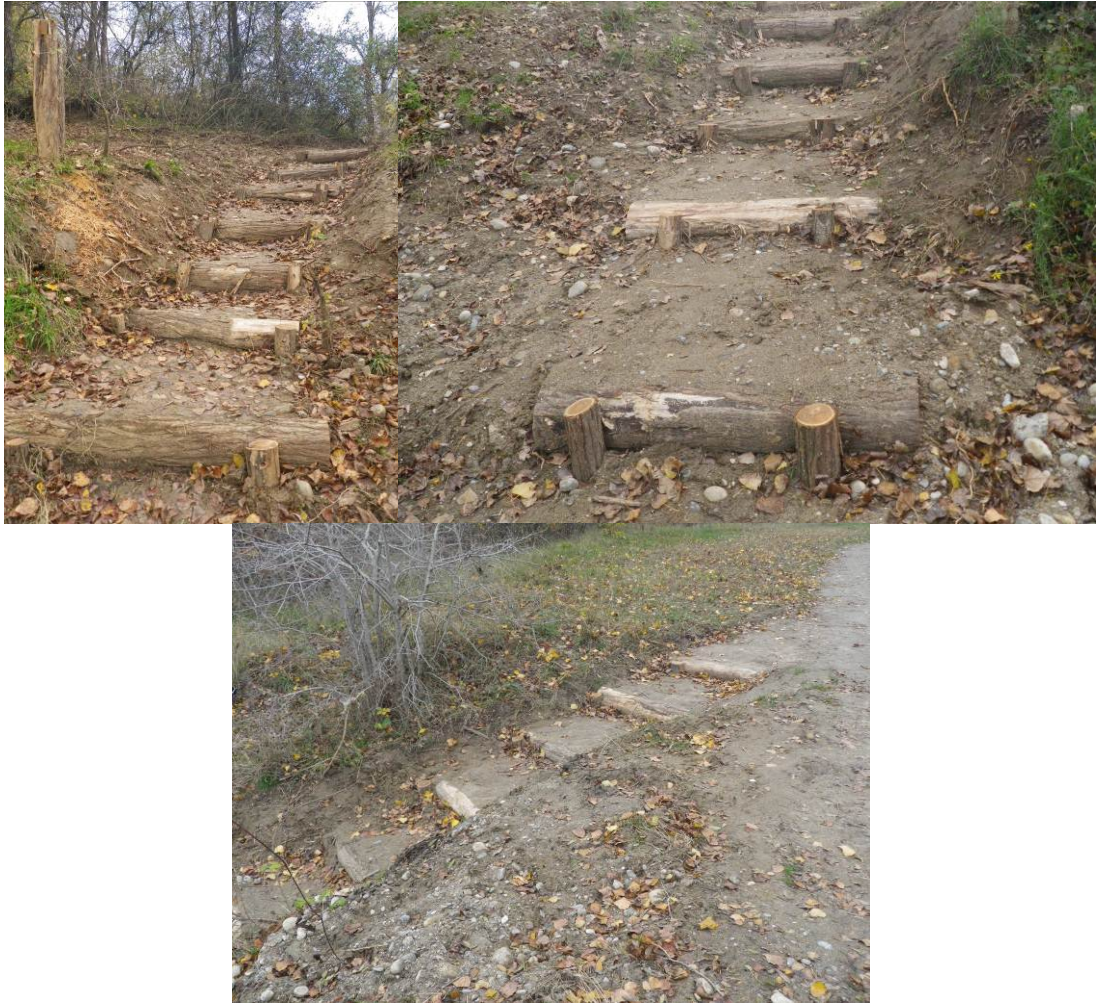
Illustration 16. Gradines en acacias sur le site de Clermont-le-Fort (MIGADO ©)
