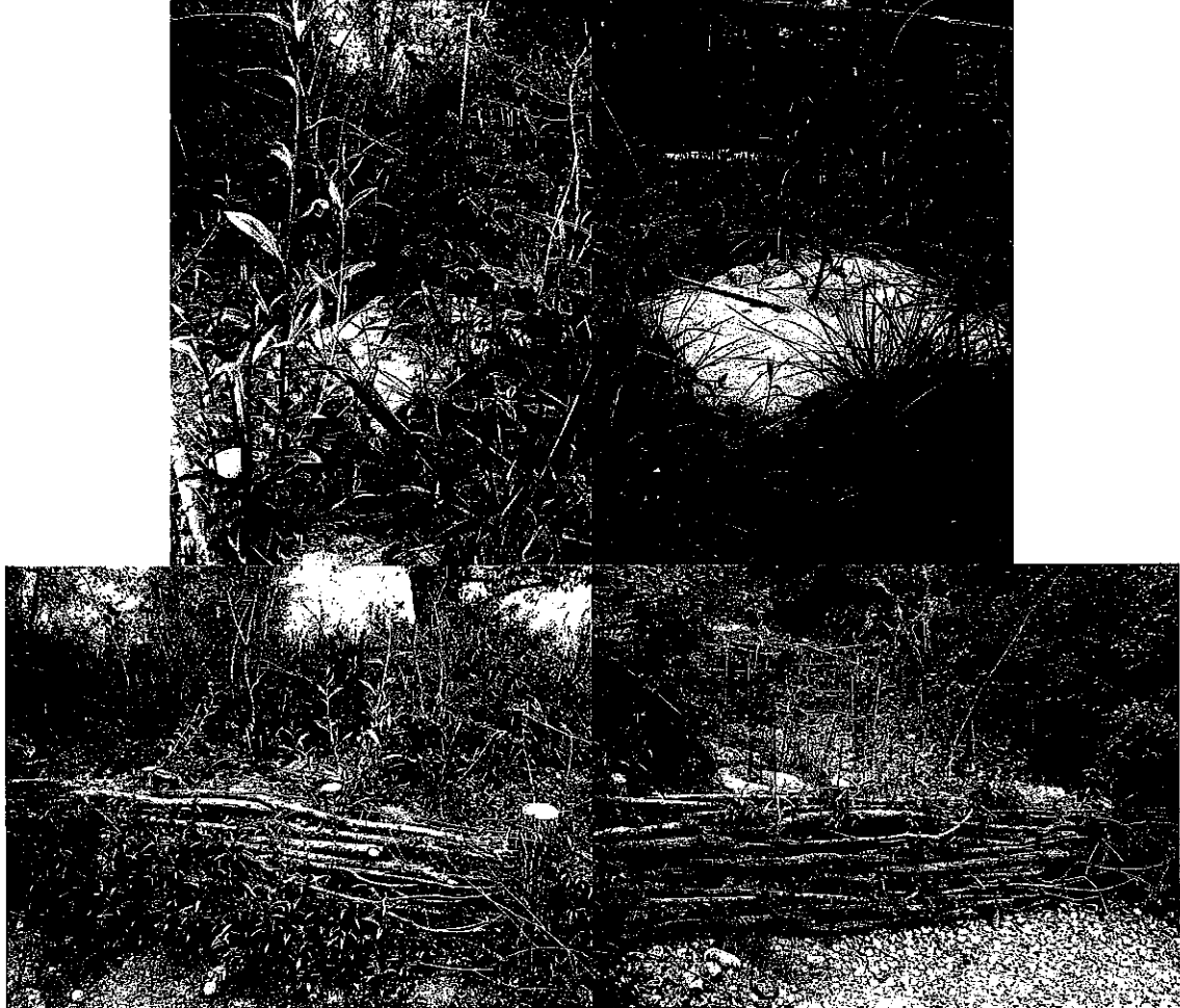
Illustration 3. Fascines créées sur les plages 1, 2 et 3 de Clermont le Fort (MIGADO ©)
