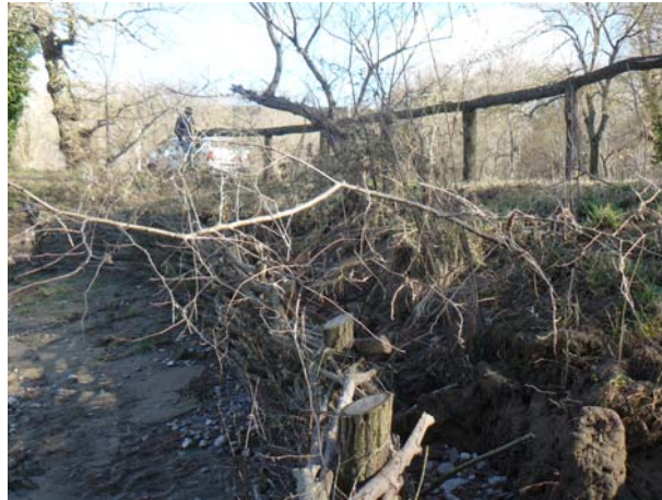
Illustration 24. Impact de la crue de 2014 sur une fascine de Clermont le Fort (Sicoval ©)
