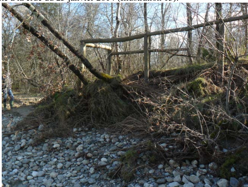
Illustration 15. Barrières qui ont dû être reprises suite à la crue de 2014 (Sicoval ©)
