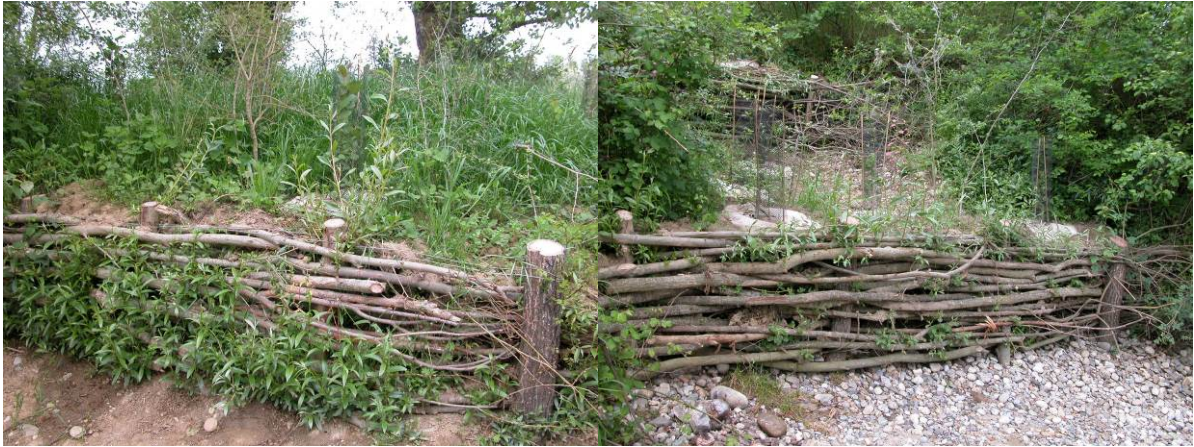
Illustration 21. Fascines créées sur les plages 1, 2 et 3 de Clermont-le-Fort (MIGADO ©)
