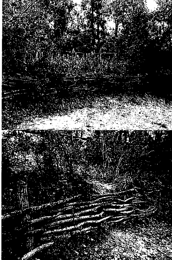
Illustration 5. Gradines de Clermont le Fort avec la reprise de la végétation et en-dessous une zone dégradée par le piétinement (MIGADO ©)
