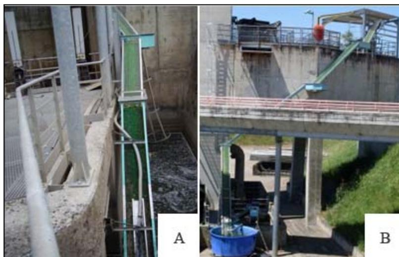
**Figure 25 : La passe à anguilles actuelle de Golfech. En A, la passe partie aval, en B, la passe partie amont avec le bassin tampon (bleu).**
