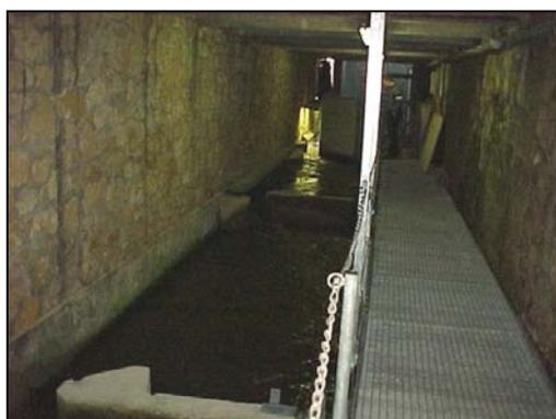
**Photo 3 : Vue d'un bassin de la passe à poissons de transfert de Tuilières**
