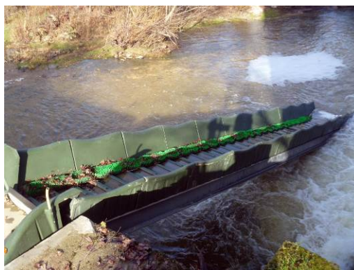
Figure 11 : Passe à canoës associée à une passe à anguilles sur la Gélise. En cours de test. Source : Yanick Birkly, 2012
