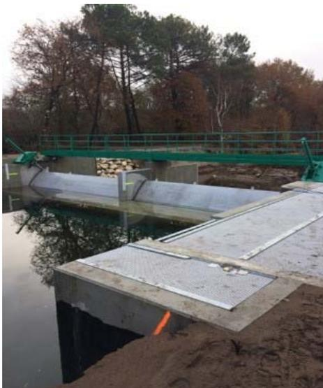
**Figure 13 : Photo de la nouvelle écluse (vannes fermées)\***
