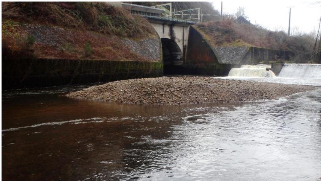
**Figure 23 : Sédiments issus du TCC qui se sont déposés à l'aval de la digue de l'usine d'Hautefage**
