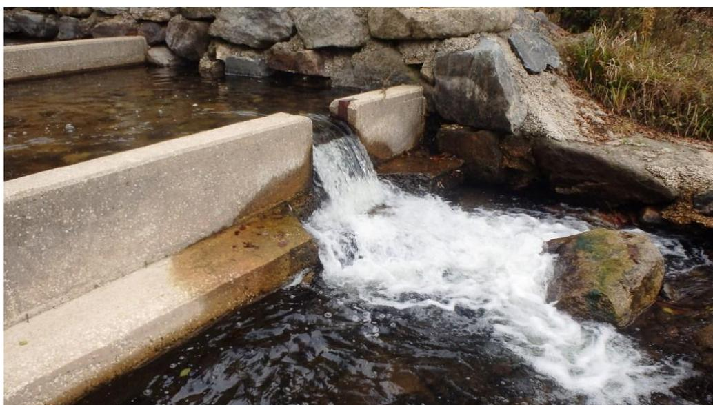
**Figure 26 : Première échancrure de la passe rustique : le jet se fracasse contre le parement béton et la fosse d'appel est peu marquée avec de faibles débits de la Dordogne**
