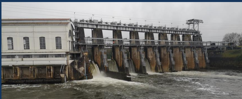
Le barrage de Tuilières avec les clapets ouverts afin de favoriser la dévalaison des smolts
