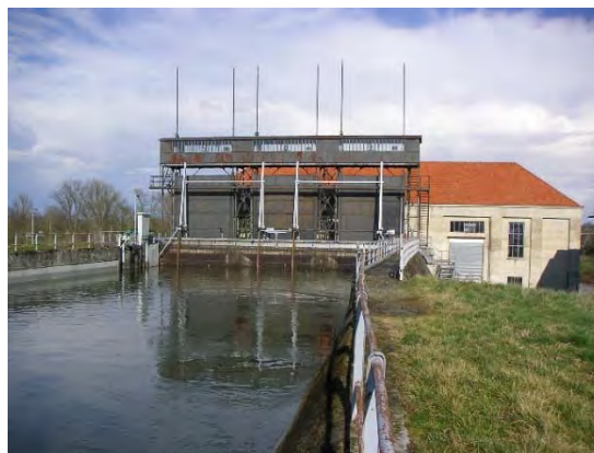
Photo 2 : Canal d'amenée et centrale de Pointis
