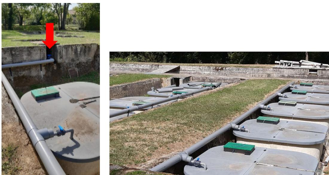
**Figure 1 : Travaux et installation 2019 à Pont Cruzet : 6 conduites d'alimentation en eau des bassins d'alevinage ont été changées (photo de droite). Pour chaque conduite, une vanne en tête a été mise en place pour faciliter le nettoyage des conduites et éviter le gel pendant l'hivernage (photo de gauche)**
