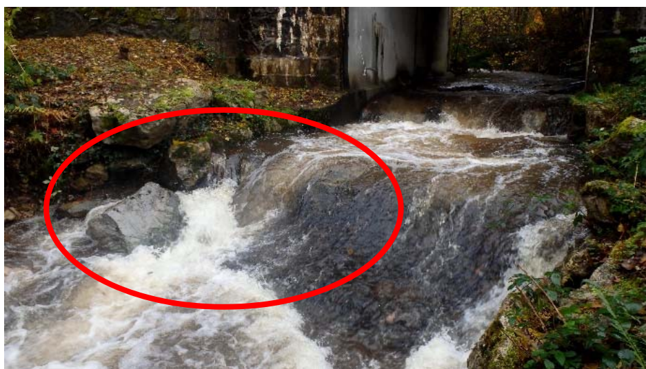
Figure 31 : Bloc perturbant le fonctionnement de la passe rustique à proximité de la confluence Combejean-Dordogne.
