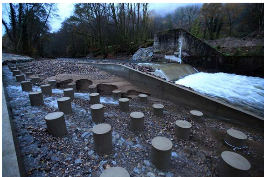
Figure 20 : Nouvelle passe-à-poisson de la digue d'Hauteffage presque entièrement comblée par les sédiments suite à la crue 12 novembre (photo prise le 24 novembre au débit réservé, usine à l'arrêt).
