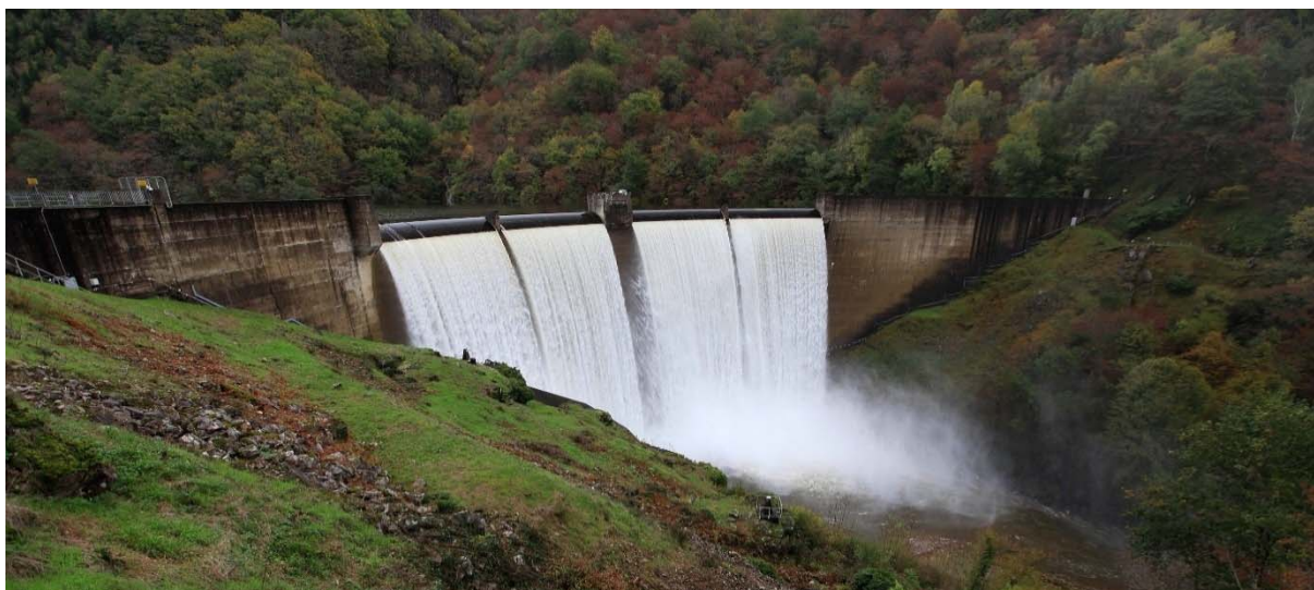
Figure 11 : Déversement au barrage de Basteyroux lors de la crue du 7 novembre 2019.
