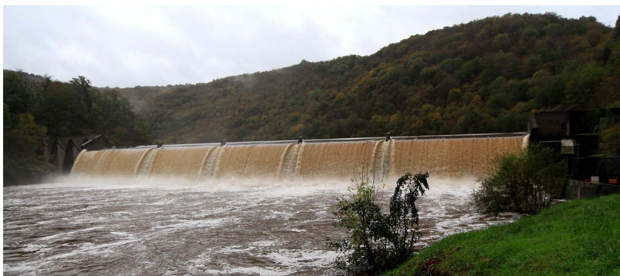
Figure 34 : Déversement à Brugales lors du premier épisode de crue de la saison (photo prise le 4 novembre à 15h, le débit était alors de 111 m³/s).
