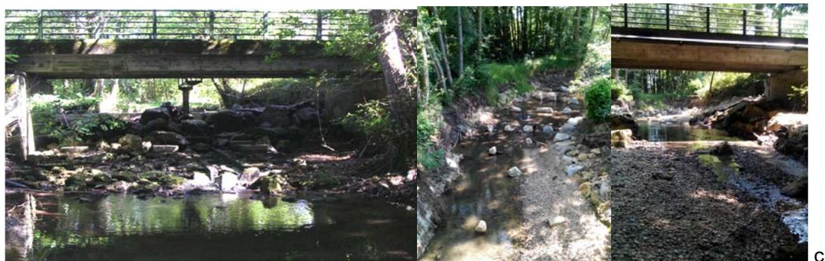
**Figure 56 : Impact des ouvrages à la migration de montaison sur Barailler/Eyraud (a), arasement de l'ouvrage aval, Moulin du Coutou b), démantèlement et réaménagement du seuil de répartition du Pont de Chadeau c)**
