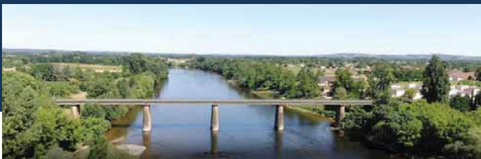
Vue aérienne du pont de Gardonne
