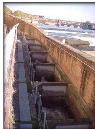
Figure 6 : Photos de la chaussée du Bazacle et de la passe à bassins.
