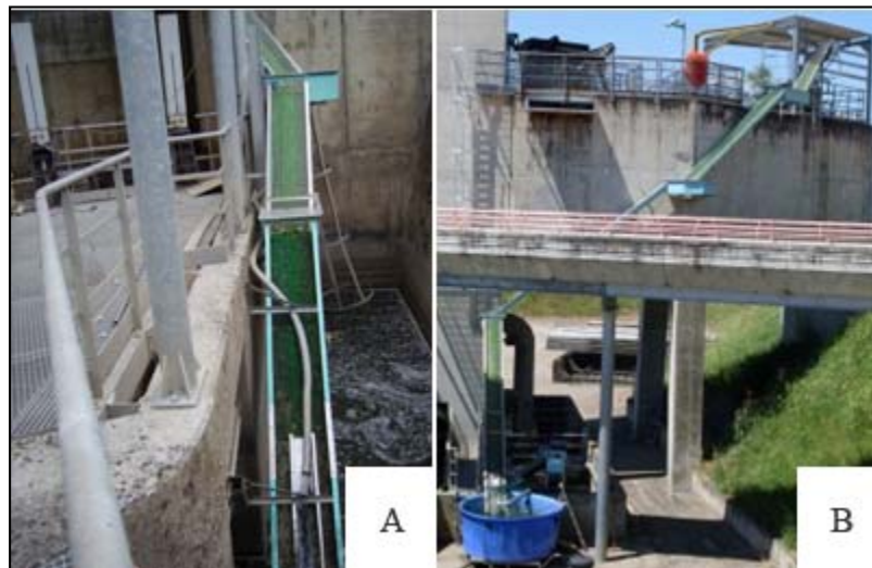
Figure 51 : La passe à anguilles actuelle de Golfech. En A, la passe partie aval, en B, la passe partie amont avec le bassin tampon (bleu).
