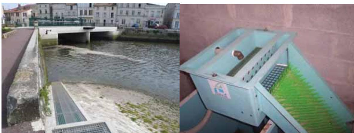
Figure 61 : Photos de la passe piège anguilles de Saujon (brosse extérieure sous grille et piège)
