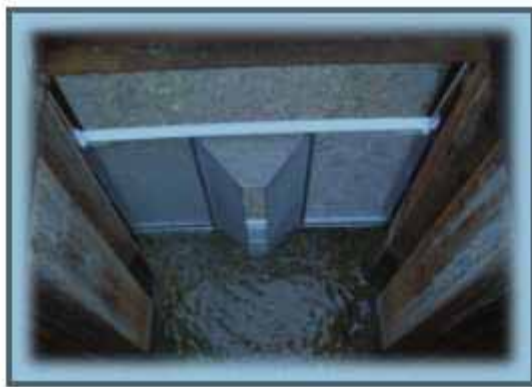
Figure 2 : Nasse anti-retour (gauche) et grilles de blocage amont. MRM/CNR
