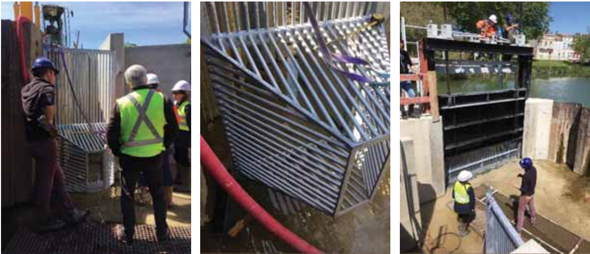
Figure 6 : Photos de chantier 30 avril 2019
