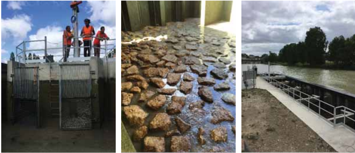
Figure 7 : Photos fin de chantier le 18 juillet 2019
