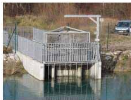
Figure 5 : Second piège (cage triangulaire) utilisé sur la passe à poissons de Livron. CNR
