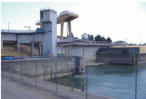
Photo 3 : Vue aval du barrage-usine de Golfech
