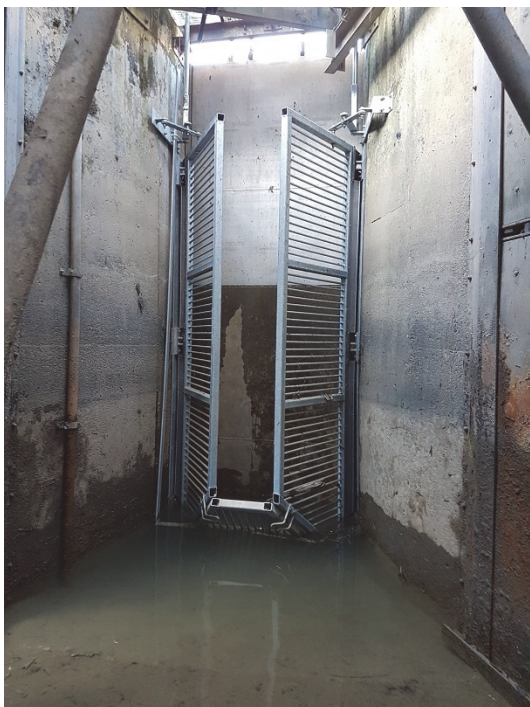
Photo 6 : Nouveau système anti-retour au niveau de l'entrée 1
