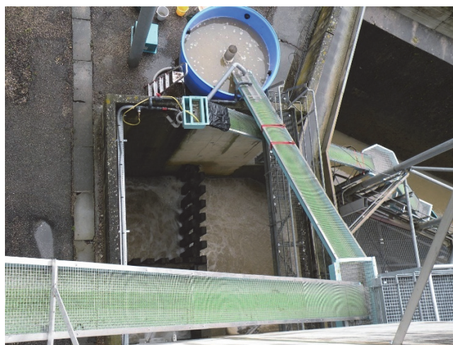
Photo 10 : Partie amont de la passe à anguilles
