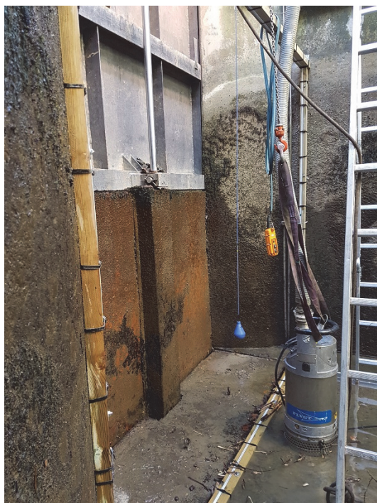
Photo 27 : Antenne BA10000, au niveau de l'entrée de la PAB
