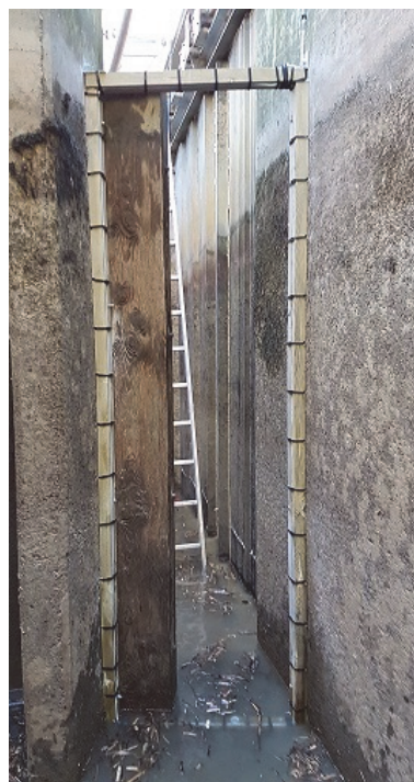
Photo 28 : Antenne BA20000 (vue depuis l'amont)
