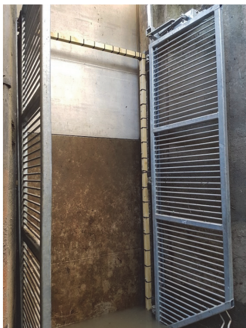
Photo 25 : Antenne GO10000 à l'entrée 1 de l'ascenseur
