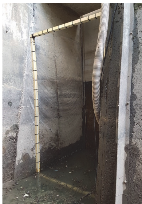
Photo 26 : Antenne GO20000 à l'entrée 2 de l'ascenseur
