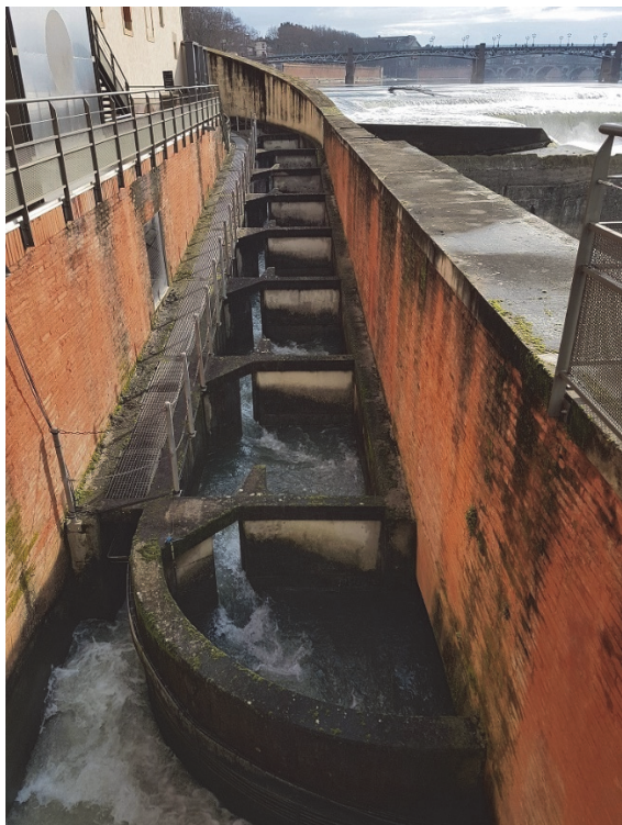
Photo 12 : Vue de la passe à bassins du Bazacle
