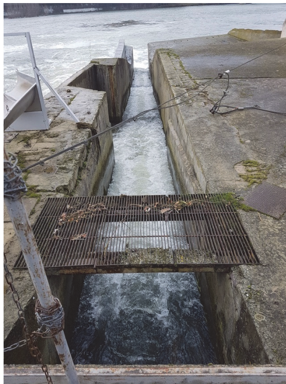
Photo 13 : Vue de la passe à ralentisseurs du Bazacle
