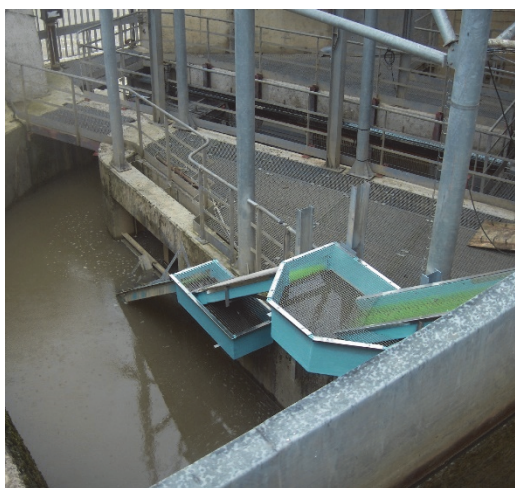
Photo 9 : Partie aval de la passe à anguilles
