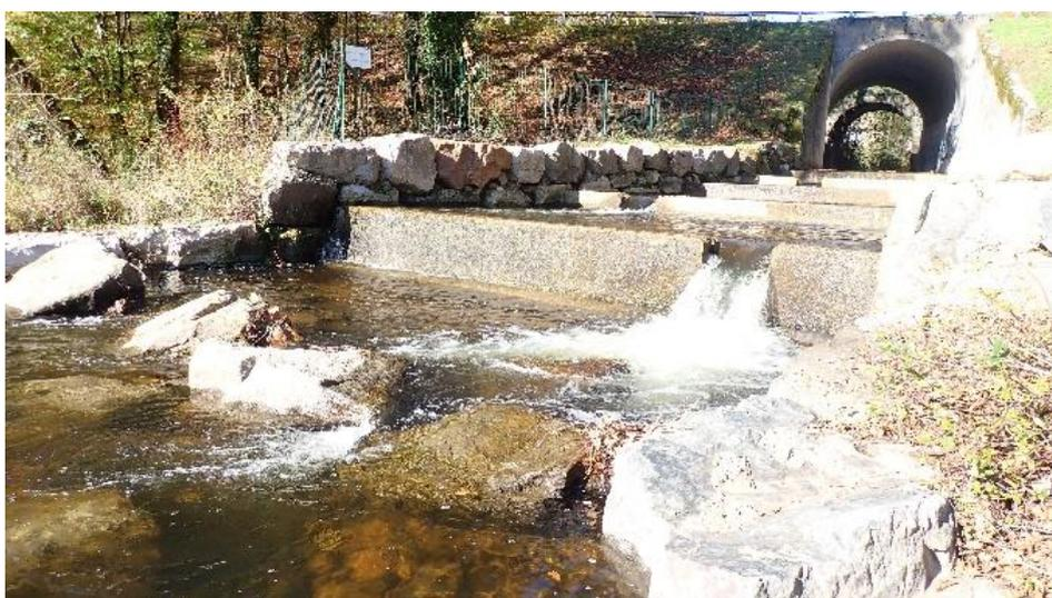
**Figure 25 : La confluence du Foulissard avec la Dordogne pour un débit de la Dordogne à Beaulieu de 86 m<sup>3</sup>/s. A ce débit l'entrée dans le dispositif est problématique avec une hauteur d'eau insuffisante et la présence d'un gros bloc qui ne facilite pas le passage des géniteurs.**
