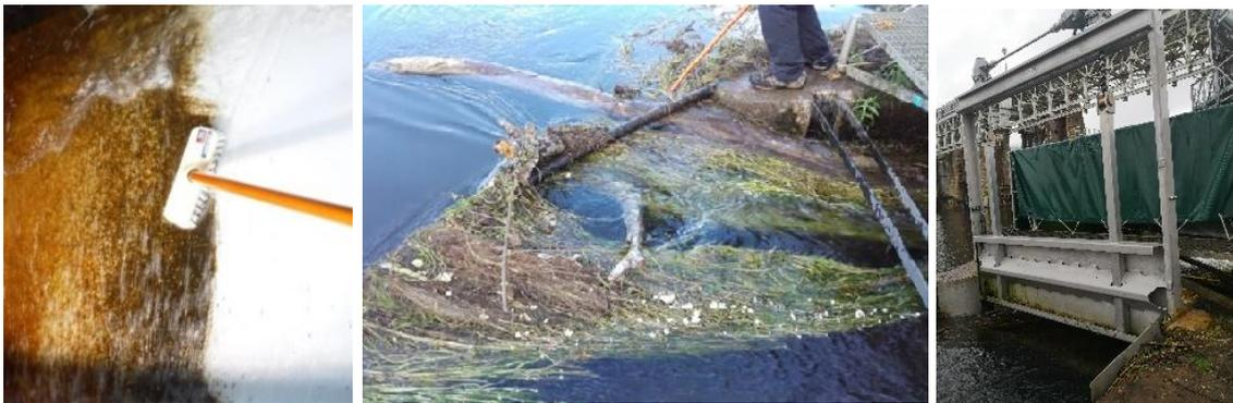
**Photo 16 : Nettoyage de la zone filmée, renoncules accumulées dans la drome, nouvelle vanne à l'amont de la passe à ralentisseurs permettant sa mise hors d'eau.**
