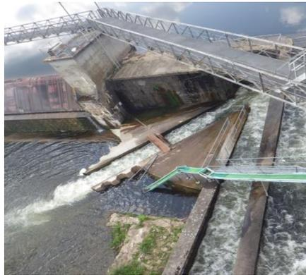
**Photo 12 : Passe à ralentisseurs et rampe à anguilles de Mauzac.**
