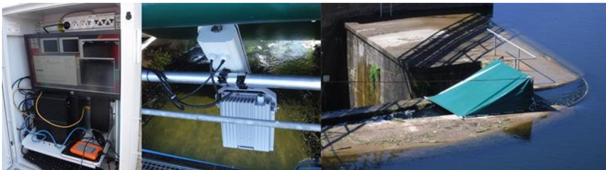
**Photo 15 : Le système vidéo de la passe à ralentisseurs du barrage de Mauzac.**
