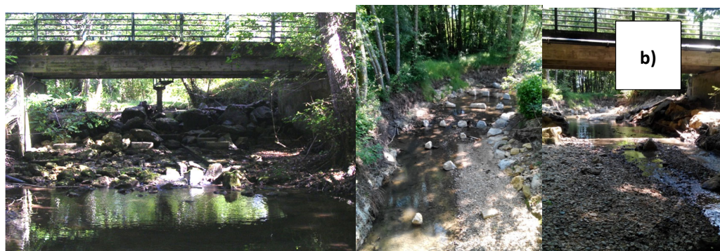
Figure 64 : Arasement de l'ouvrage aval, Moulin du Coutou a), démantèlement et réaménagement du seuil de répartition du Pont de Chadeau b)
