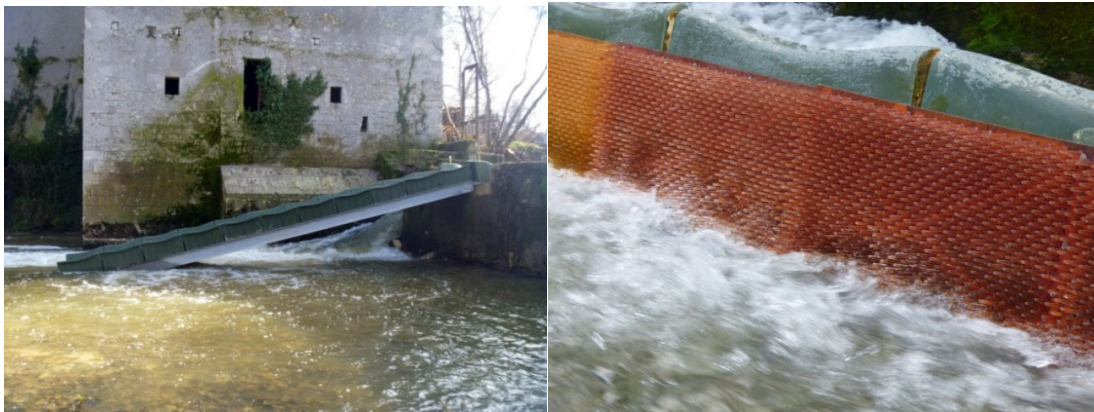
Figure 66 : Franchissabilité des obstacles à la montaison sur la Gélise (a), passe à canoë et nouveau tapis de reptation (b)
