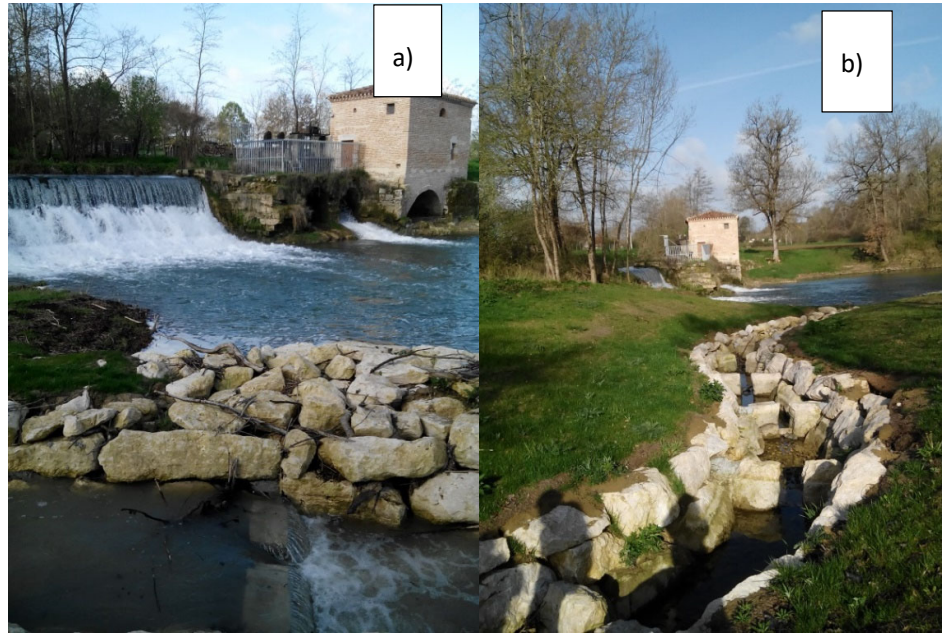
Figure 65 : Evaluation de l'efficacité de la rivière de contournement sur le site du Moulin de Castels (Tarn et Garonne) (a), site aménagé (b)
